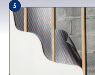
Masonry Wall / Mur en maçonnerie / Pared de mampostería
